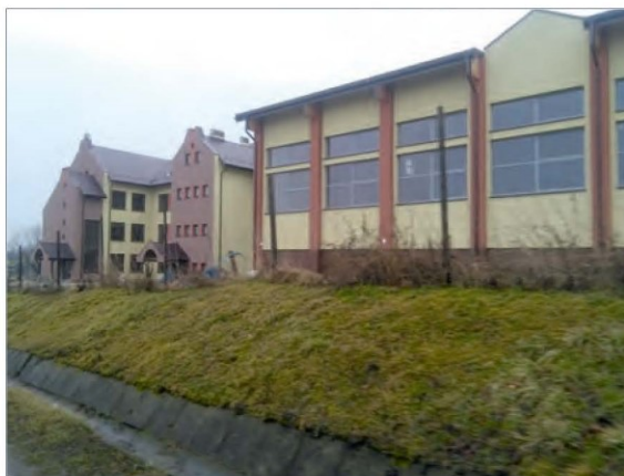
Fot. 1 Hala gimnastyczna w Chłopicach
