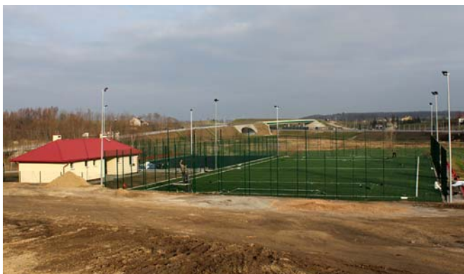
Kompleks boisk Orlik 2012 w Boratynie - w trakcie budowy, październik 2012
