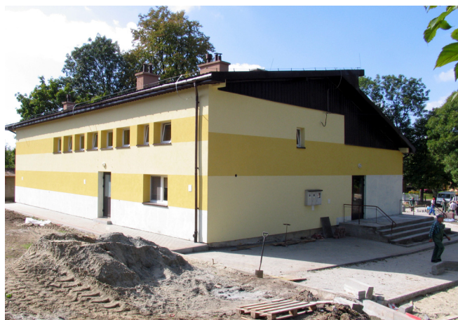
Budynek świetlicy wiejskiej w Boratynie - roboty remontowe są na ukończeniu
