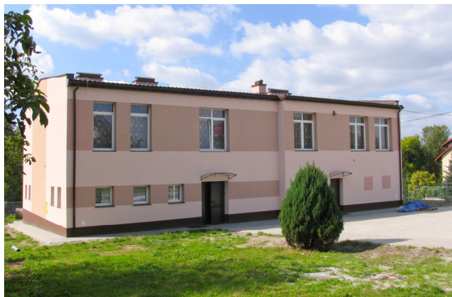
Budynek świetlicy wiejskiej w Lutkowie po remoncie
