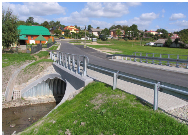
Nowo wybudowany most w Dobkowicach
