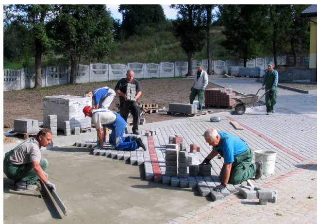
Prace przy układaniu nawierzchni parkingu k. świetlicy wiejskiej w Boratynie
