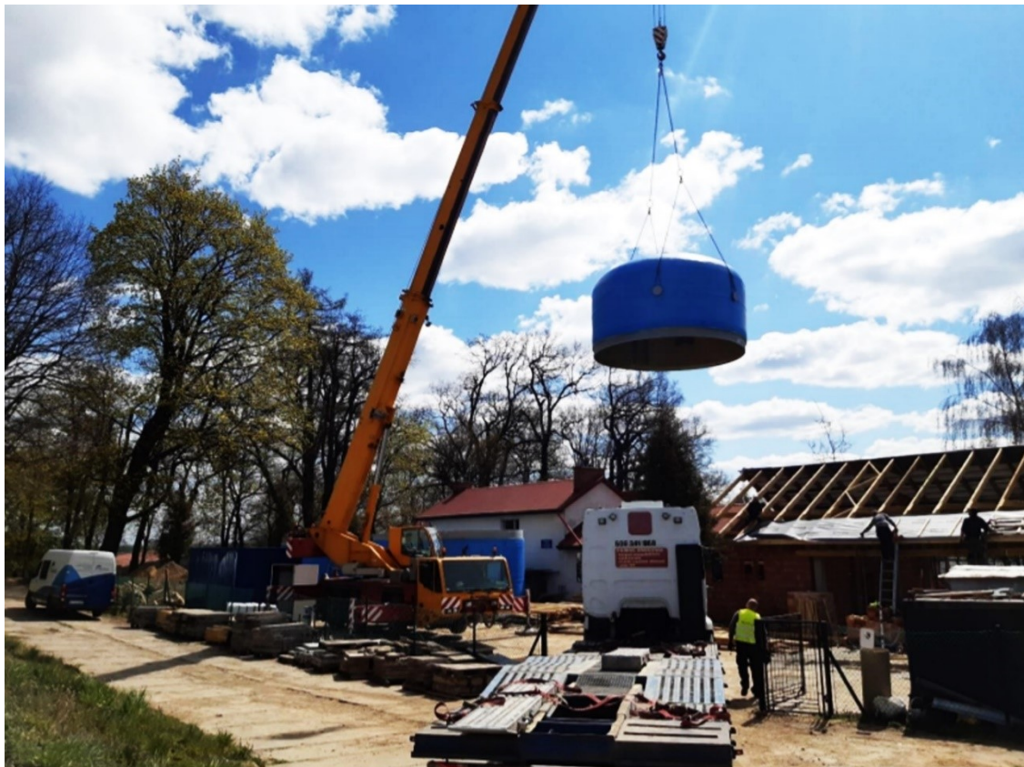
Oczyszczalnia ścieków w miejscowości Chłopice w trakcie rozbudowy (źródło: zbiory własne)
